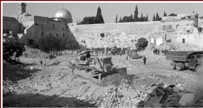
I lavori di demolizione
