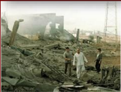
Edificio per le telecomunicazioni a Beirut distrutto dagli israeliani il 25 giugno 1999
