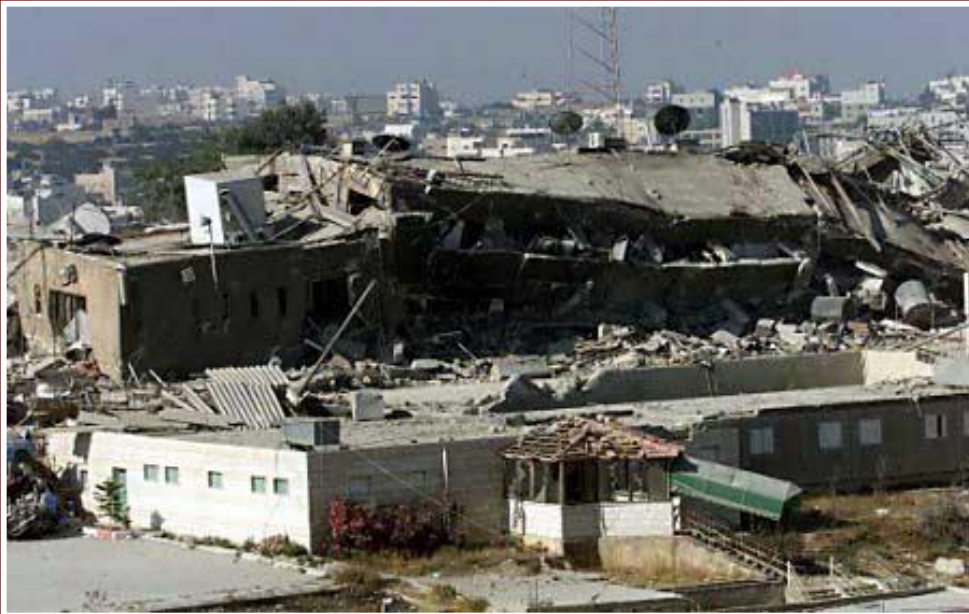
La caserma di Hebron distrutta il 29. 06.2002
