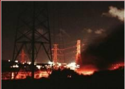
1999 Centrale elettrica libanese distrutta dagli israeliani
