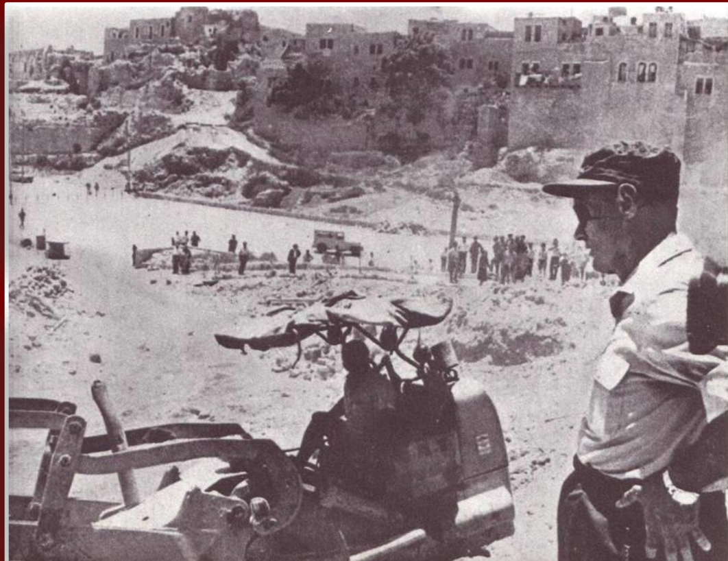
Il generale Dayan osserva i lavori di demolizione del quartiere arabo di al-Mugariba a Gerusalemme est, conquistato dalle sue truppe. Tutto questo per creare una piazza davanti al Muro del pianto.
