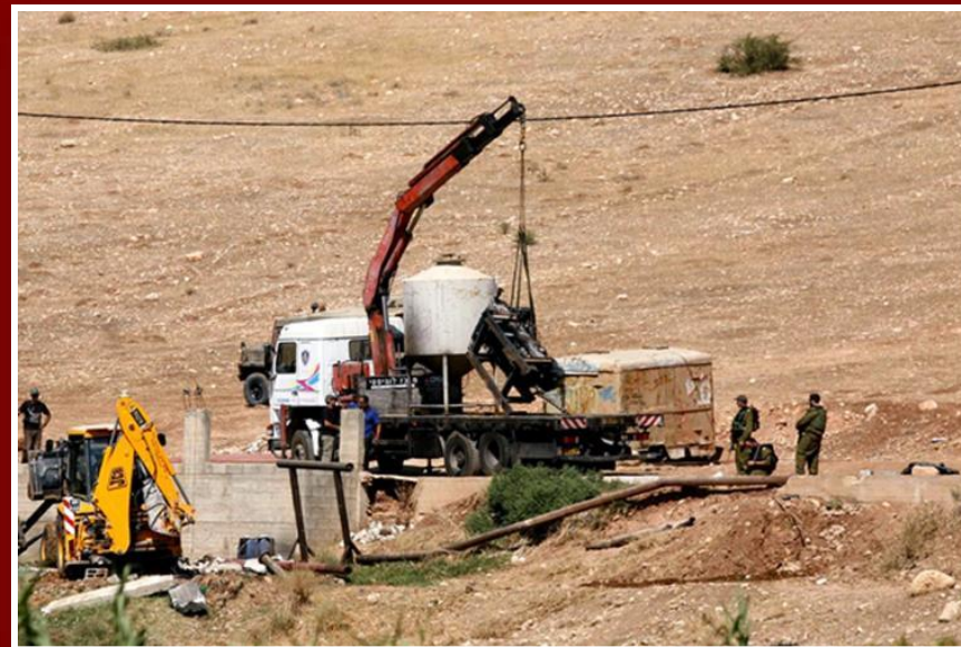
Demolizione di un pozzo acquifero e confisca delle attrezzature a An Nasariya, Valle del Giordano. 8 settembre 2011
