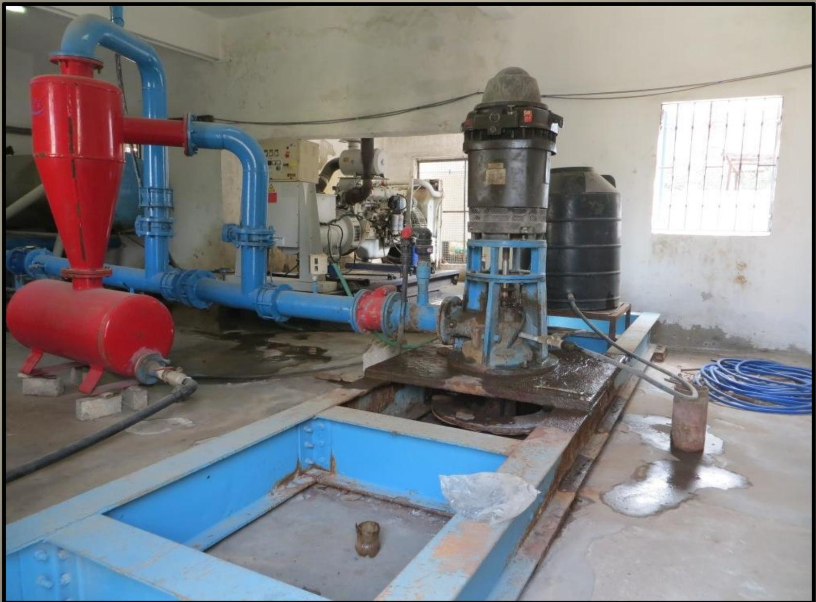
**Gaza : una stazione di pompaggio alimentata da un generatore diesel che a sua volta dipende dalle forniture di combustibile.**
