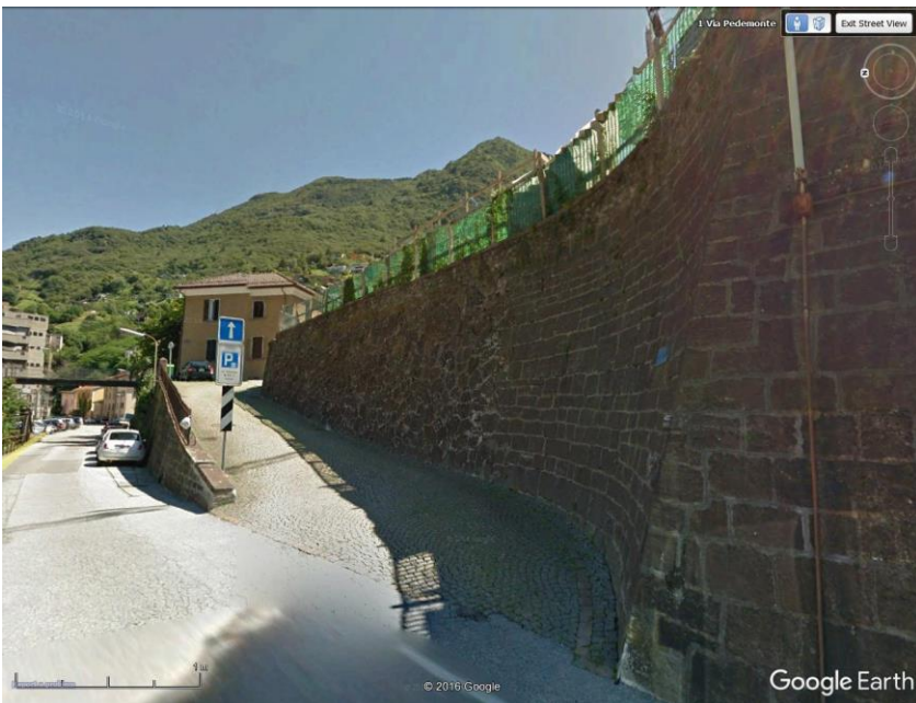
Passerella FFS e Daro bassa.
