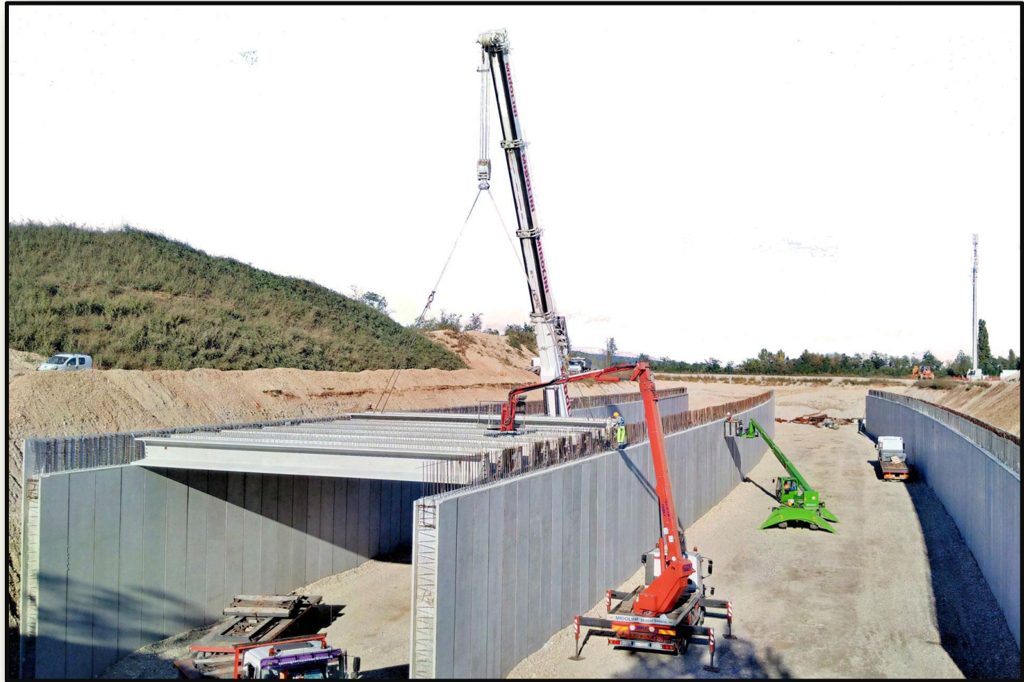
Costruzione di una galleria artificiale prefabbricata 33
