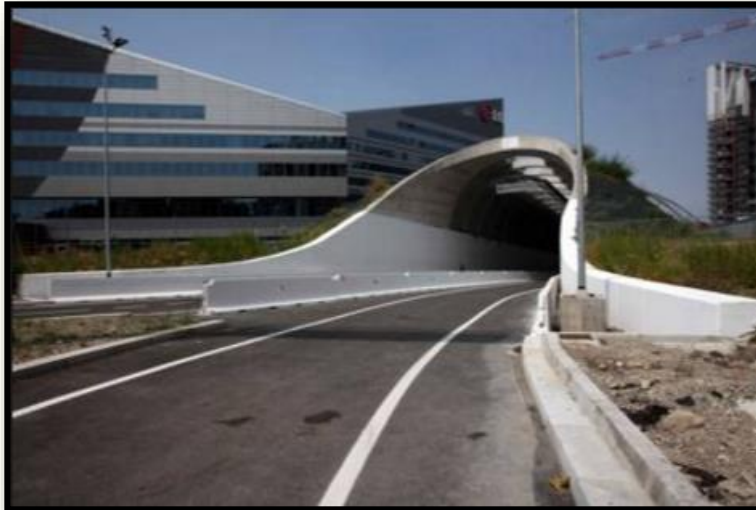
Galleria artificiale coperta a Milano - Via Portello
