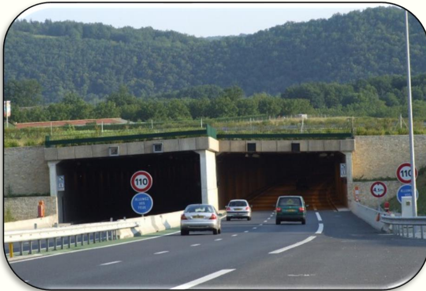
Galleria artificiale coperta
