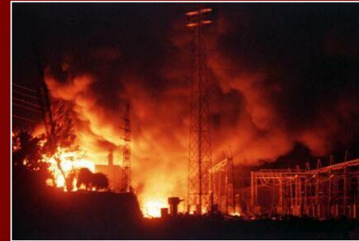
La centrale électrique de Joumhour détruite par les Israéliens le 8.2.2000
