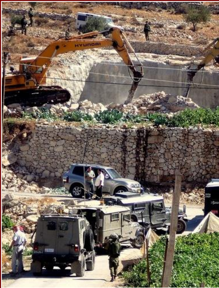
هدم خزان مياه جوفي 03.09.2009
