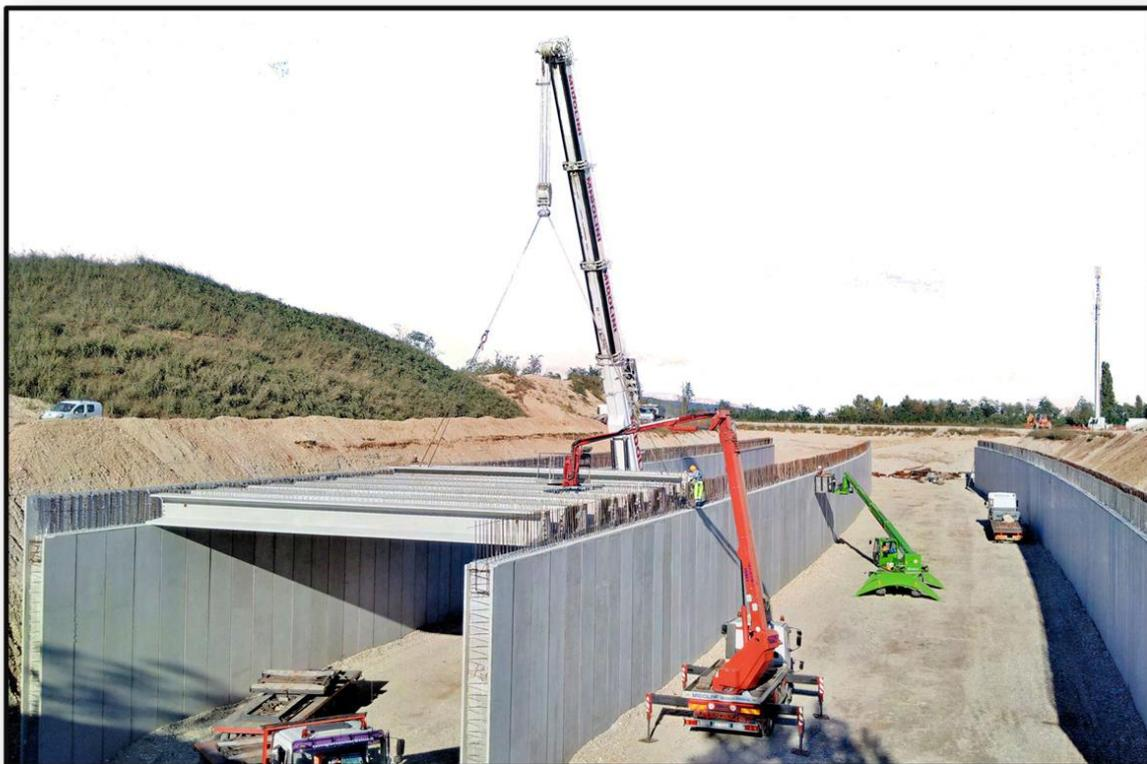
**Bau eines vorgefertigten künstlichen Tunnels**
