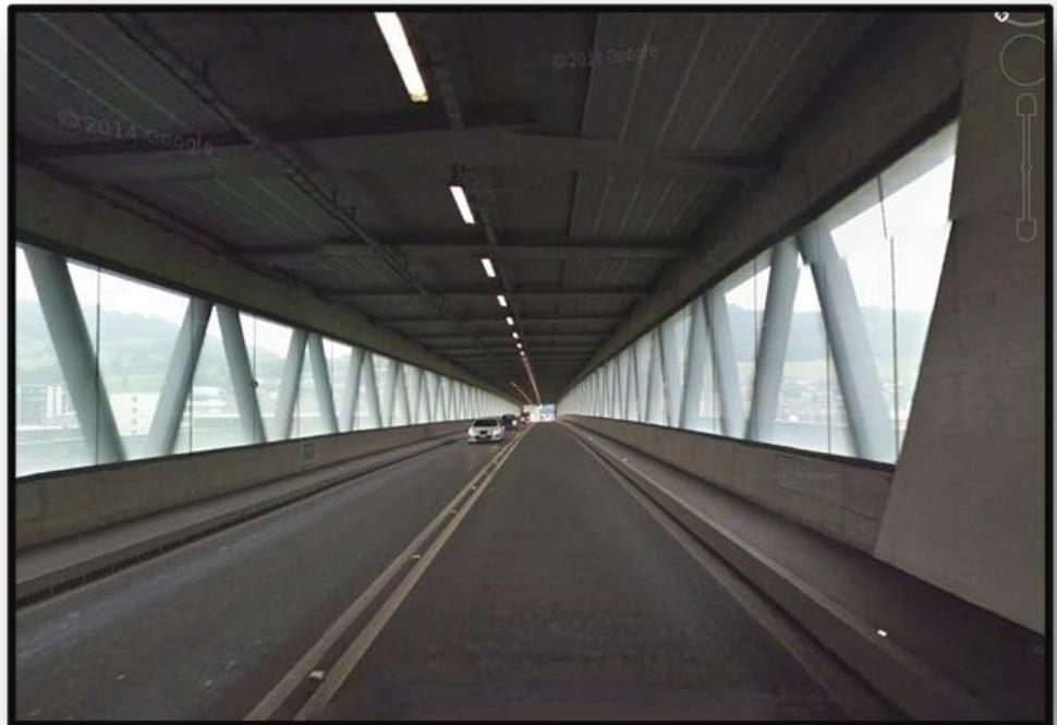
In Quartino kann der kritische Bereich der Magadino-Ebene zwischen dem Nordportal des Quartino-Bironico-Tunnels und der Brücke über den Fluss Ticino mit einem schallgedämmten Viadukt überquert werden.
