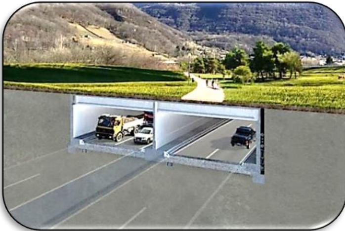
**Unterirdischer künstlicher Tunnel. Es entsteht viel Aushubmaterial und berührt den Grundwasserspiegel. Hohe Kosten.**
